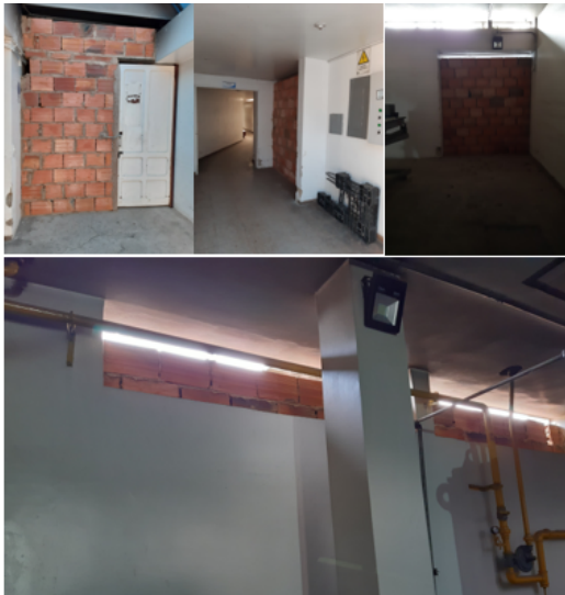
Fotografía 5. Cerramientos Físicos de los hornos
